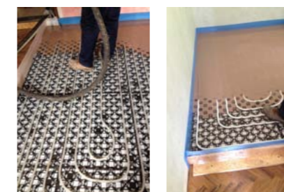
Posa su pavimentazione esistente
